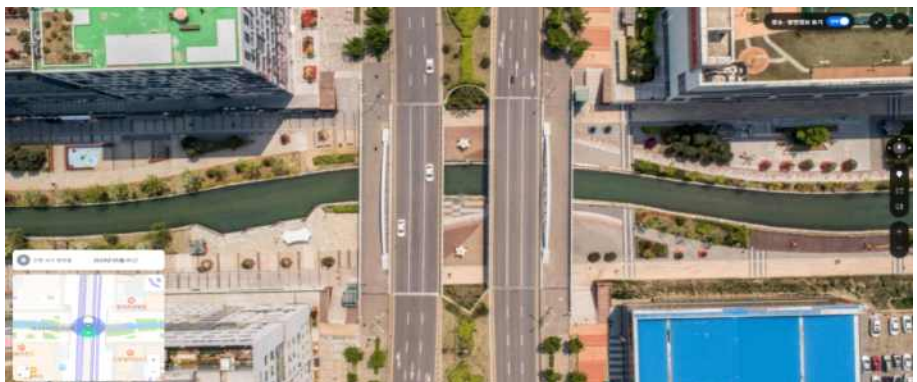
<교량 상부구조, 상부도로, 보도부, 교량 옆 계단, 엘리베이터 등>
