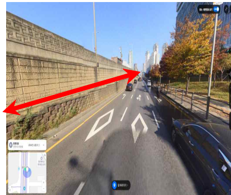
<옹벽 및 방음벽 촬영 예시>
